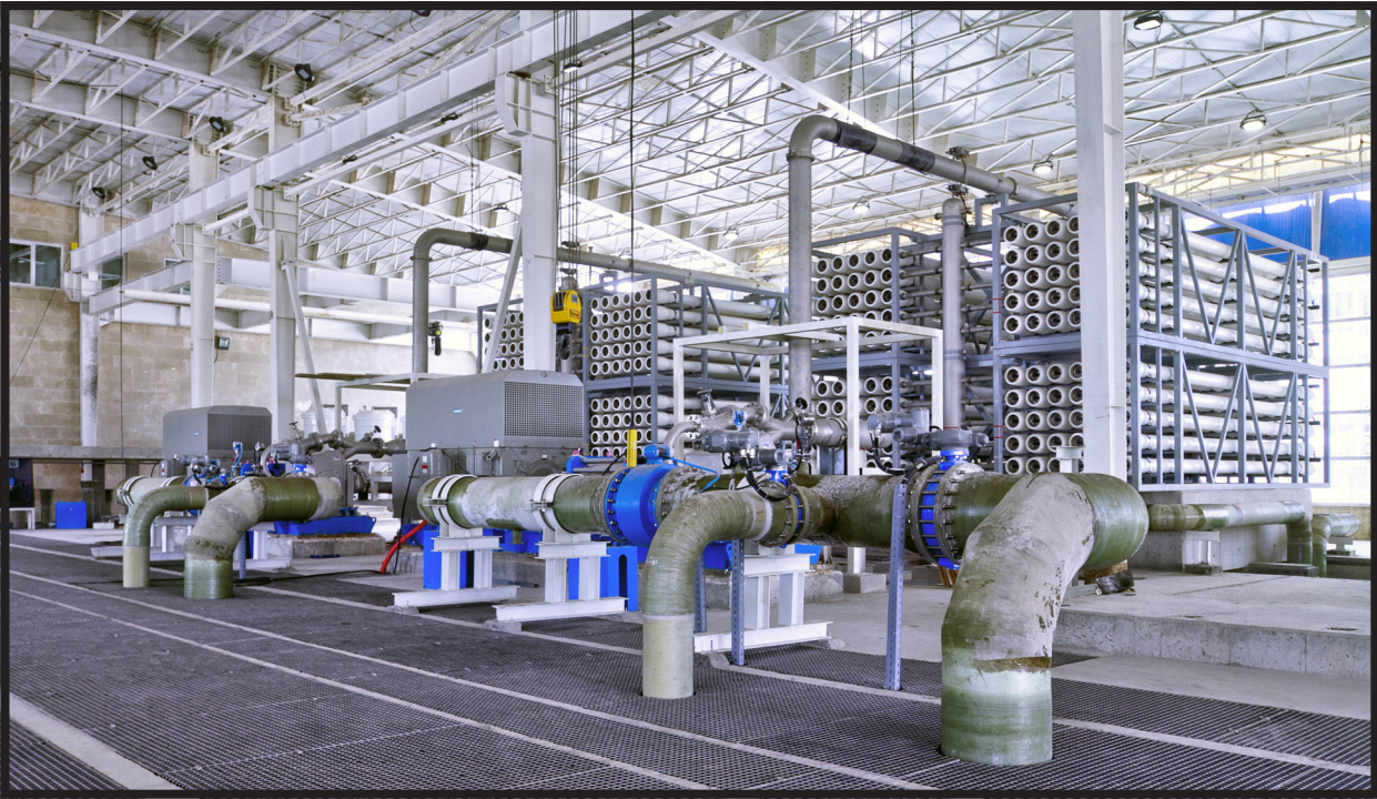
▲ واحد آب‌شیرین‌کن صنعتی می‌تواند تا روزانه ۵ هزار متر مکعب آب قابل شرب تولید کند
